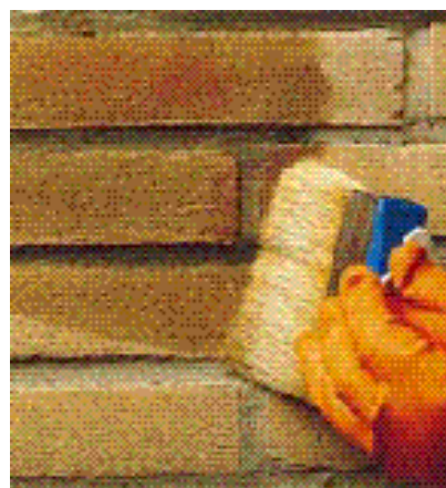
Нанесение ANTIPLUVIOL S щеткой.
