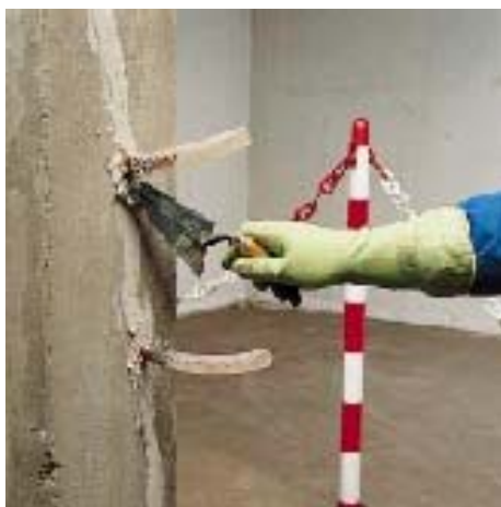
фиксация инъекционных трубок клеем ADESILEX PG1
