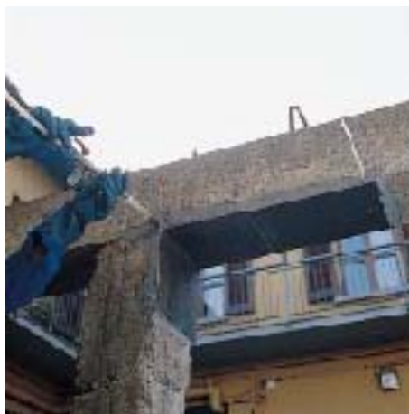
ремонт бимса путем инъекции ЕРОJET
