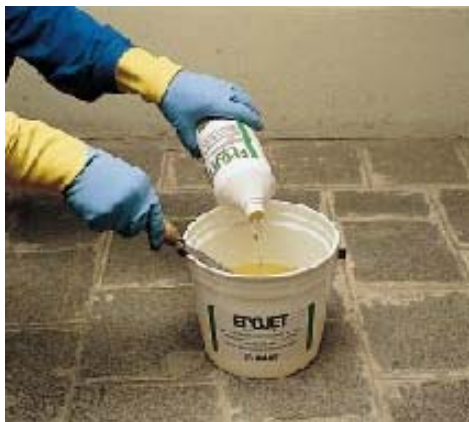
смешивание компонентов EPOJET
