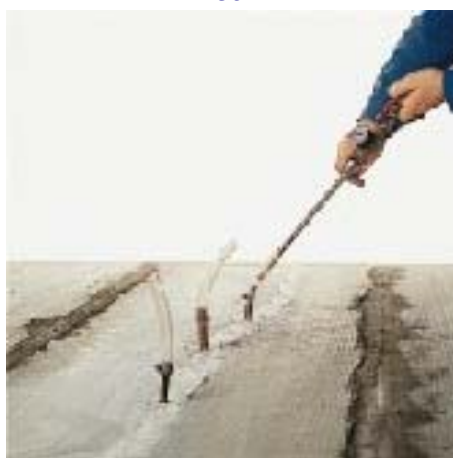
ремонт горизонтальной поверхности путем инъекции ЕРОJET
