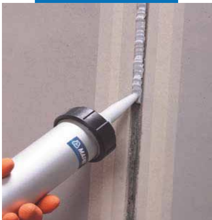
Нанесение Maпeflex PU40
