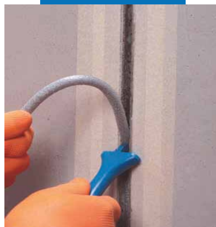
Укладка шнура Мапefoam вовнутрь шва
