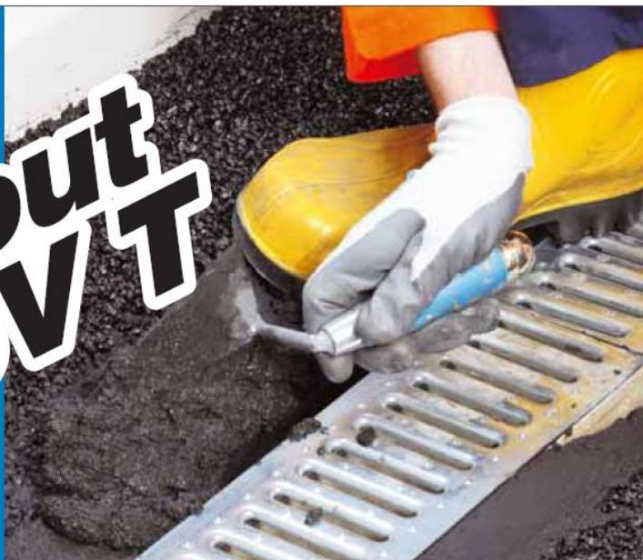
**Быстрохватывающийся и быстротвердеющий тиксотропный раствор с компенсированной усадкой, применяемый для ремонта бетона и монтажа дренажных труб, канализационных люков и городских декоративных элементов.**
