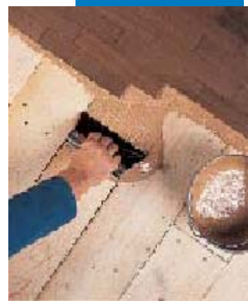
Монтаж реек по половицам с LIGNOBOND
