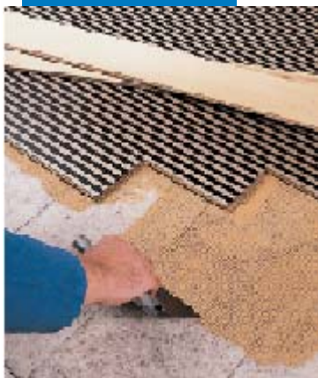
Монтаж цветных реек по существующему паркету с LIGNOBOND
