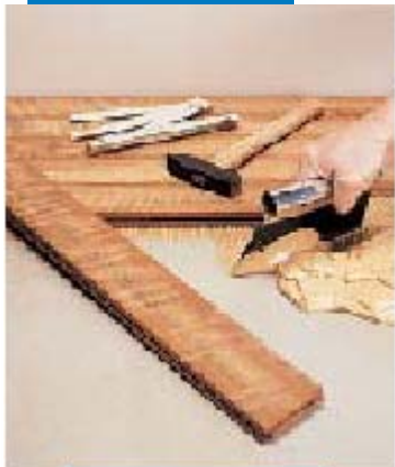
Монтаж реек с LIGNOBOND
