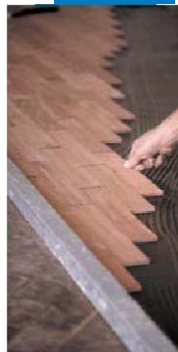
Пример установки дощатого настила на существующих керамических плитках с LIGNOBOND
