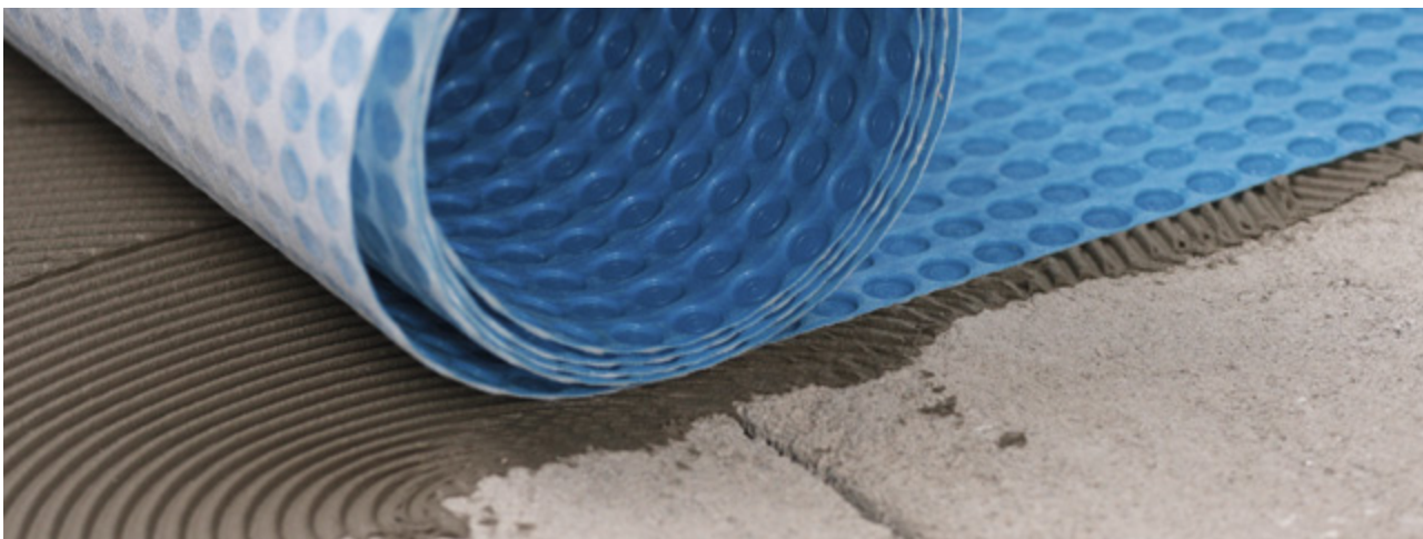
Укладка Mapeguard UM 35 на цементную стяжку с нарезанными швами
