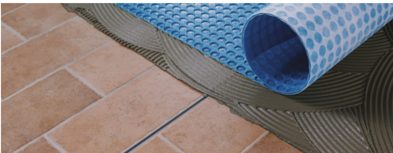
Укладка Mapeguard UM 35 на потрескавшуюся керамическую плитку с компенсационными швами
